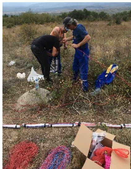
Фигура 5.Заряд-„гирлянд“ от патронирано емулсионно ВВ тип Powergel MAGNUM
