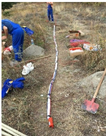
Фигура 5.Заряд-„гирлянд“ от патронирано емулсионно ВВ тип Powergel MAGNUM
